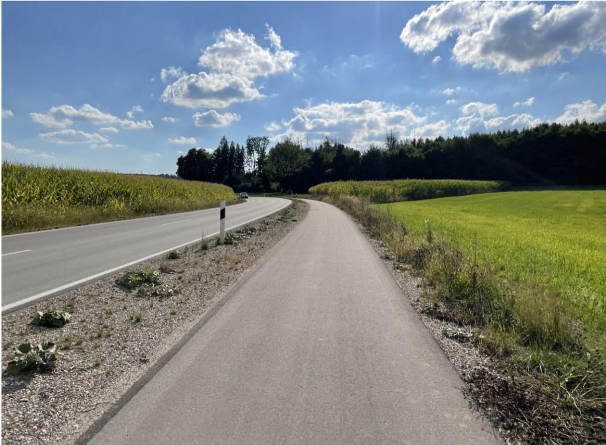
Innerorts sollen Zweirichtungradwege wegen des erhöhten Verkehrssicherheitsrisikos durch das Befahren in Fahrtrichtung links vermieden werden.
