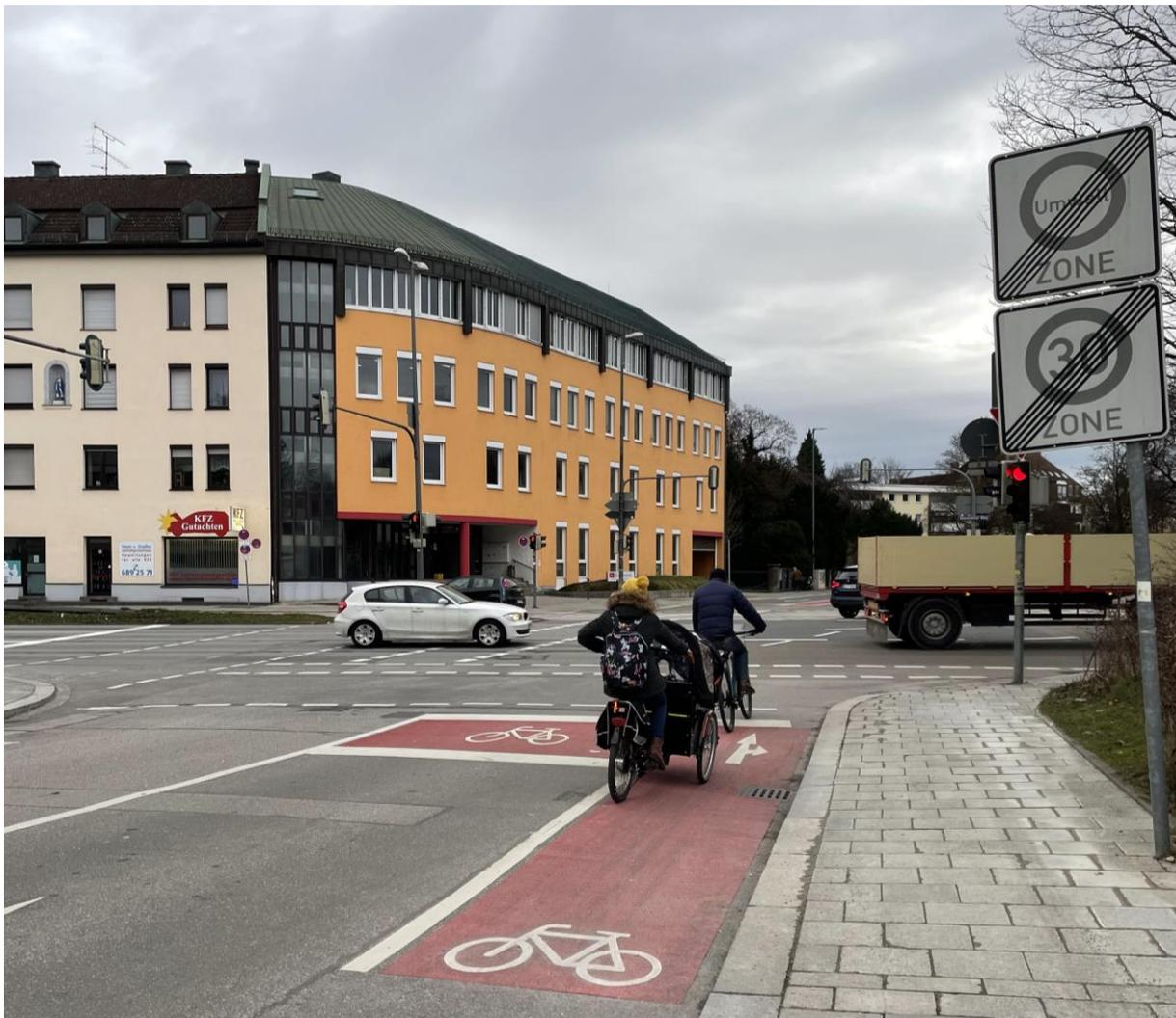
Gute Sichtbeziehungen an signalisierten Knotenpunkten zwischen Rad- und Kfz-Verkehr sowie Markierungen von vorgezogenen Haltelinien, aufgeweitete Radaufstellstreifen (ARAS) ggf. mit Roteinfärbung erhöhen die Sicherheit von Radfahrenden an Knotenpunkten.
