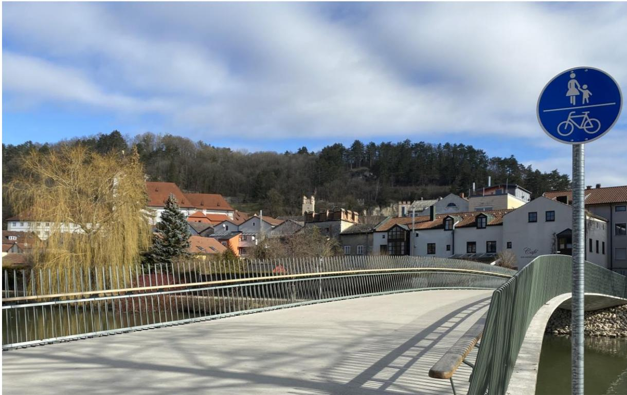
Es ist auch darauf zu achten, dass ein Schutzgeländer in einem ausreichenden Abstand zum Fahrbahnrand des Radwegs montiert ist, um beispielsweise ein versehentliches Hängenbleiben mit dem Fahrradlenker auszuschließen. Die Enden des Geländers sind abzurunden bzw. schräg abzusenken, damit die Gefahr einer schweren Verletzung infolge eines stumpfen Anpralls vermindert wird.
