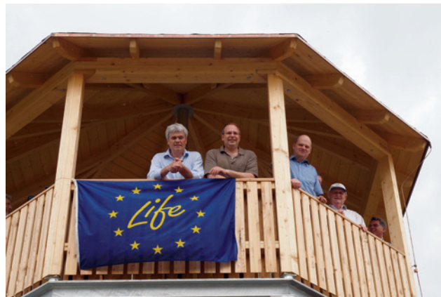
Das Bild zeigt Bürgermeister Bernhard Storath (links) und Landrat Christian Meißner (zweiter von links) bei der „Erstbesichtigung“ des Turms.
